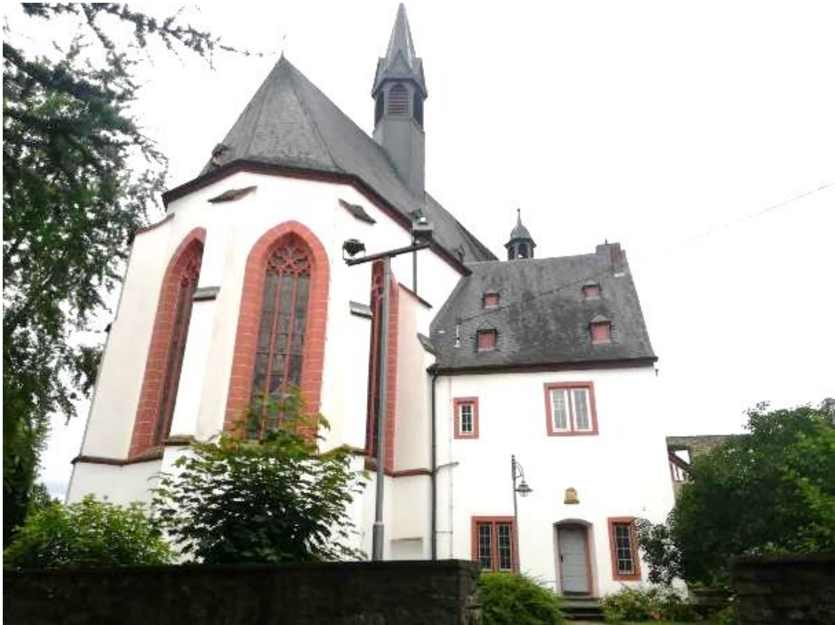
Abbildung 13: Die ortsbildprägende katholische Kirche St. Georg (Quelle: Eigenes Foto)
