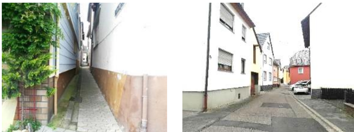
Abbildung 41: Enge Gasse mit fehlender Beleuchtung im Bereich der Backesgasse (links) und der schlechte Zustand der Fußwege in der Hochstraße (rechts) (Quelle: Eigenes Foto)
