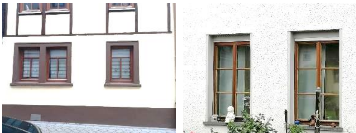
Abbildung 17: Fensterdetails: links : Holzsprossenfenster mit T-Teilung und farblich abgesetzten Fenstergewänden, rechts : mehrteiliges Holzsprossenfenster (Quelle: Eigenes Foto)
