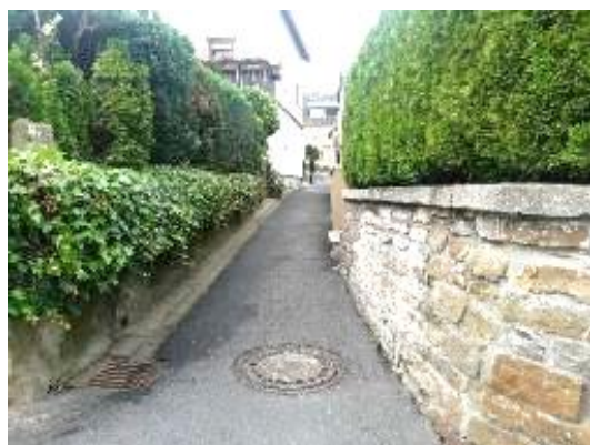
Abbildung 20: Einfriedung als halbhohe Bruchsteinmauer mit Hecke (Quelle: Eigenes Foto)
